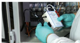
6. Quite la película de protección de la cinta de montaje ubicada en la parte inferior de la unidad principal, y después coloque la unidad en posición y aplique una presión ligera durante 30 segundos. Repita esto con el foco de UV-C.
