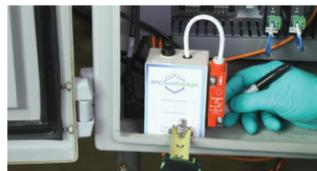
4. Ubique un fuente de alimentación adecuada dentro de su tablero de control – ya sea por el tomacorriente o los cables de alimentación eléctrica. Después, con el tablero de control desconectado, realice las conexiones eléctricas a la fuente de alimentación del tablero de control.
