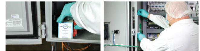
7. Conecte el foco a la unidad principal del EPIC Panel Sterilight usando el cable de alimentación del foco provisto.
